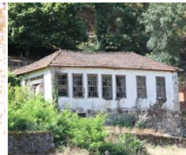
Fig. 32 Antigo edifício de hospedagem com salão, quarto e cozinha
