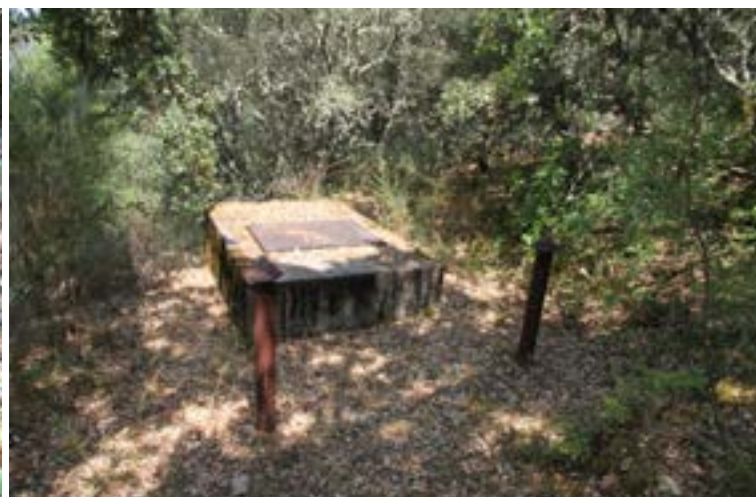
Fig. 25 Reservatório de água denominado de Mãe-d'água
