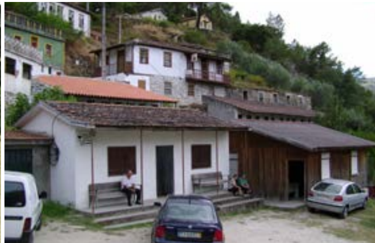
Fig. 19 Estruturas da década de 80 e pré-fabricado do Gabinete de Tratamentos ORL. Fonte: Sítio all about Portugal
