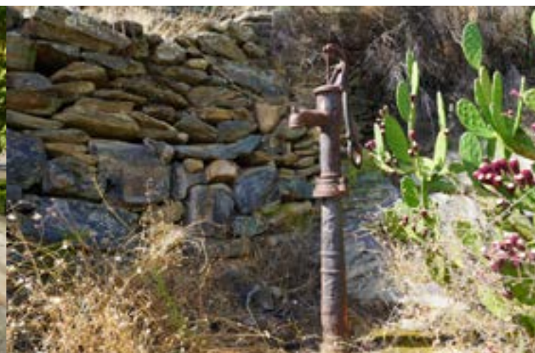
Fig. 18 Fonte Santa, Estrutura de Ferro Fundido (Fotografia de 2023)
