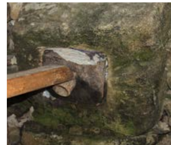
Fig. 13 Aspeto da extremidade inferior do cubo e focinheira no cabouco do moinho nº1
