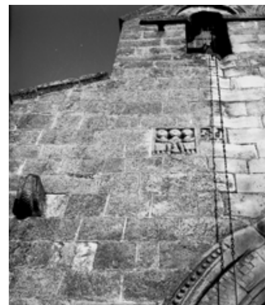
Fig. 2 Fachada principal da Igreja de Santiago Maior, Adeganha, 1950 (destaque para as três Marias esculpiradas no granito)
