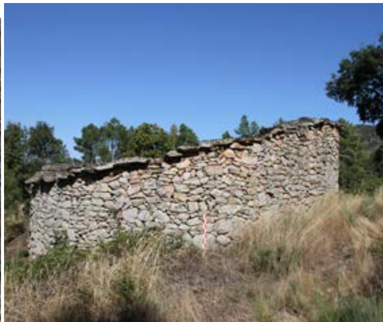
Fig. 2 Vista exterior da estrutura n.º3
