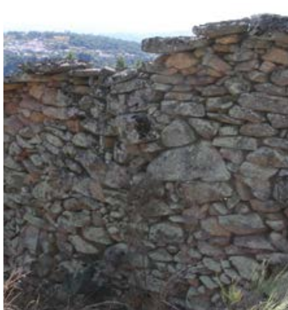
Fig. 1 Vista exterior da estrutura n.º10
