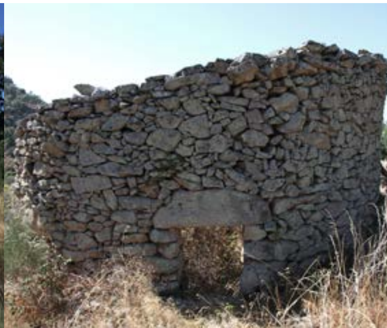
Fig. 3 Vista exterior da porta da estrutura n.º1
