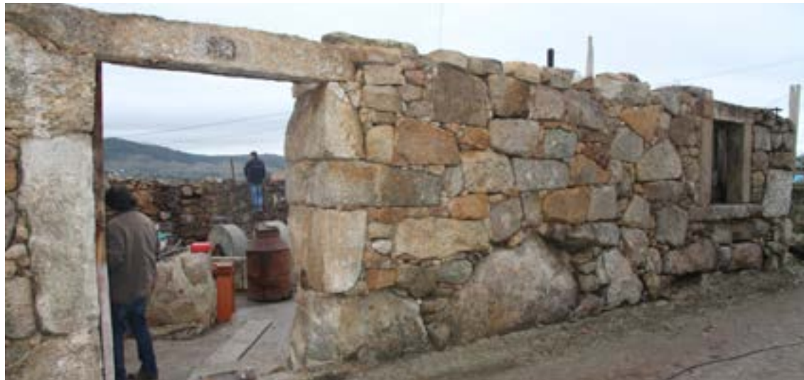
Fig. 1 Lagar da Lavandeira durante a fase de obra
