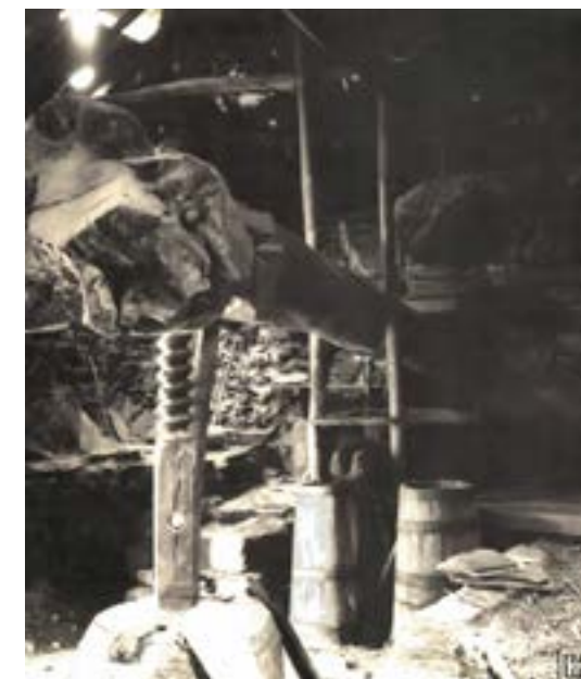
Fig. 14 Prensa de vara
