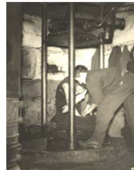
Fig. 6 Enseiramento no lagar de azeite de Fontelonga
