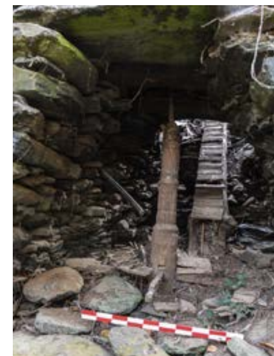
Fig. 4 Interior do inferno ou cabouco do moinho do Ti Morgado (nº 37), ainda com o rodizio horizontal e cubo de madeira
