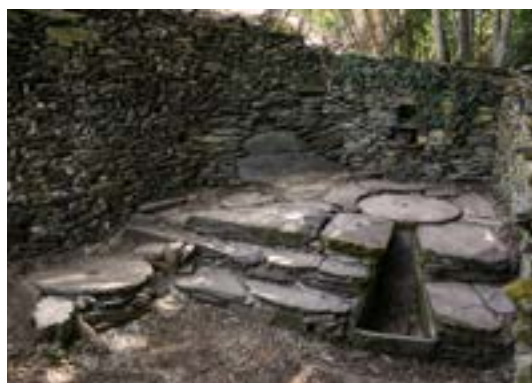
Fig. 6 Interior do Moinho das Teixeirainhas (nº34). Com o seu piso elevado e lajeado, é visível que apenas um par de mós seria operacional
